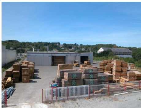
Figure 35: Séchoir à bois de l'entreprise Potier (Source Potier)
